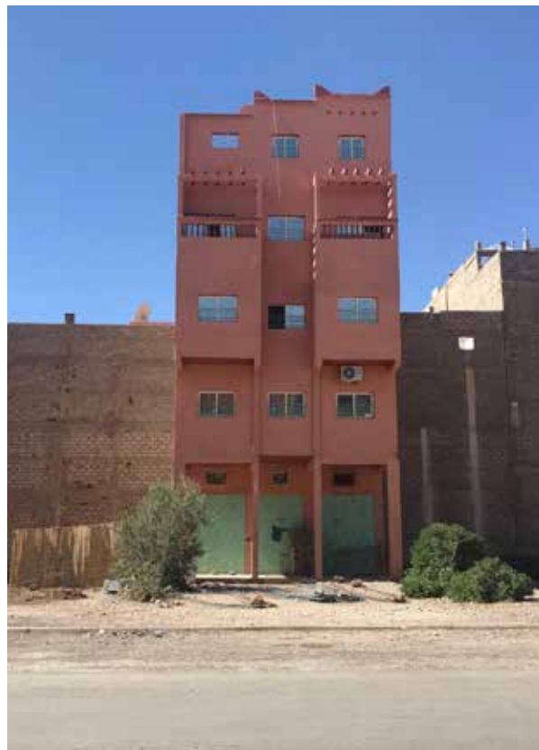
Immeuble type dans un quartier en construction près de Al Whada - Octobre 2018
