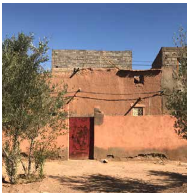
Une maison en pisé dans le quartier Al Qods à Ouarzazate – octobre 2018
