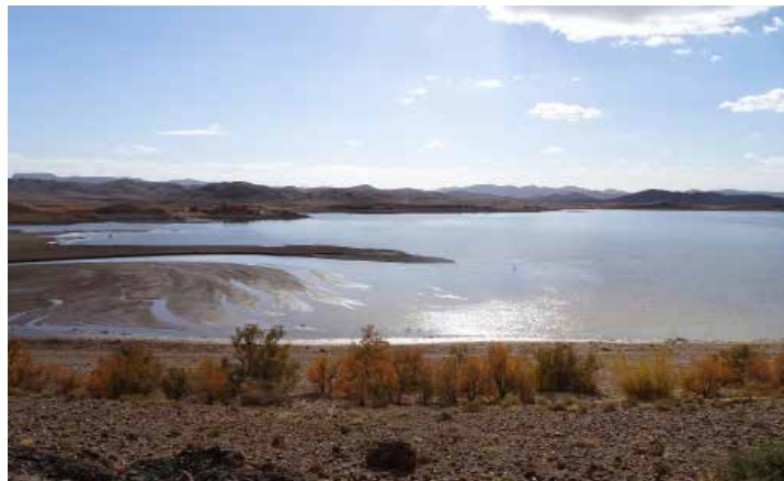
Le lac de barrage Al Mansour Al Dahbi
