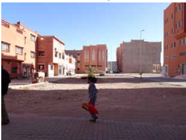
Situation d'aridité de traitement d'un espace résidentiel potentiellement qualitatif
