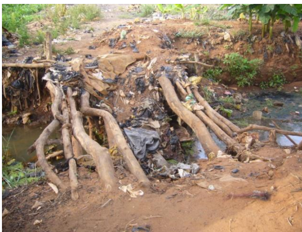
Donoukin : Pont de fortune réalisé pour traverser le bas-fond.
