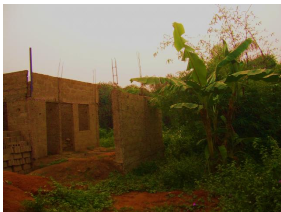
Une maison en cours de construction dans le bas-fonds.
