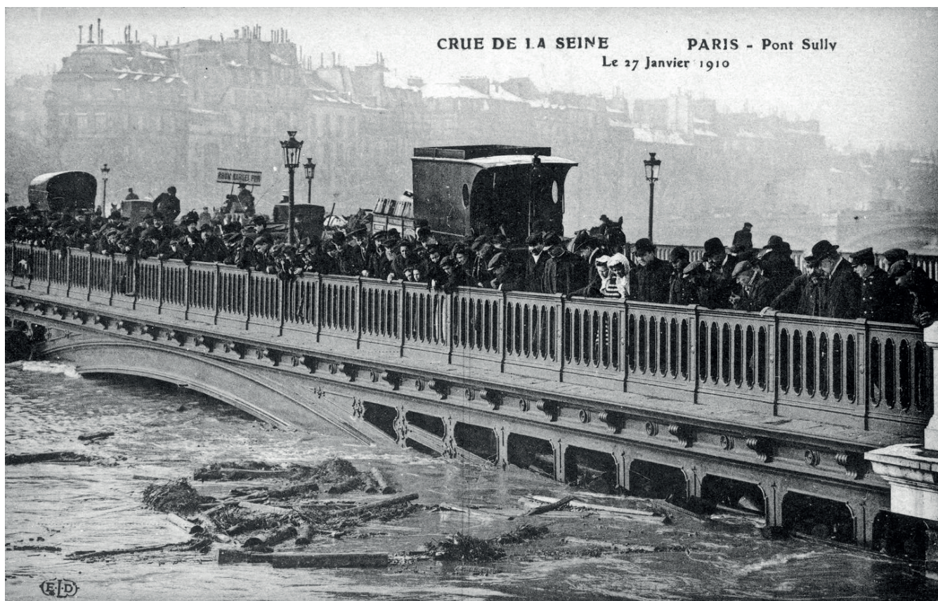
La crue de la Seine en 1910, Pont Sully, Paris
