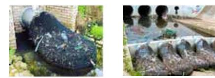
Filets placés à la sortie des canaux d'assainissement
