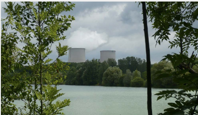
Vue sur la centrale de Nogent-sur-Seine
