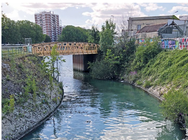
30. La confluence entre la Vieille Mer et la Seine, à Saint-Denis. Source : APUR
