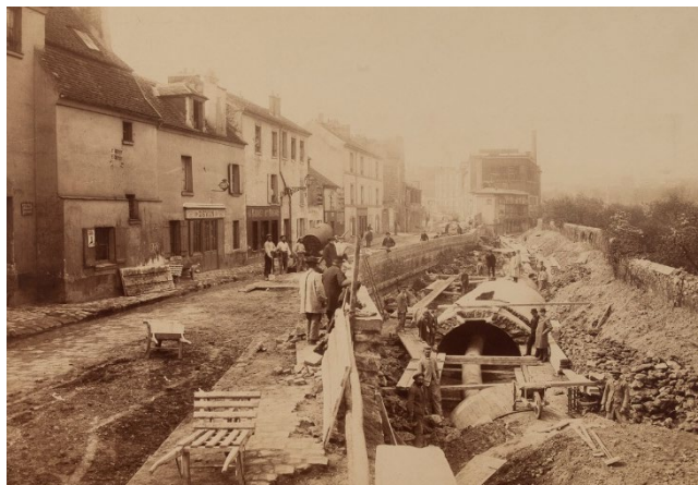
26. Travaux de couverture de la Bièvre, 1905. Photo : Henri-Cimara Godefroy, Musée Carnavalet
