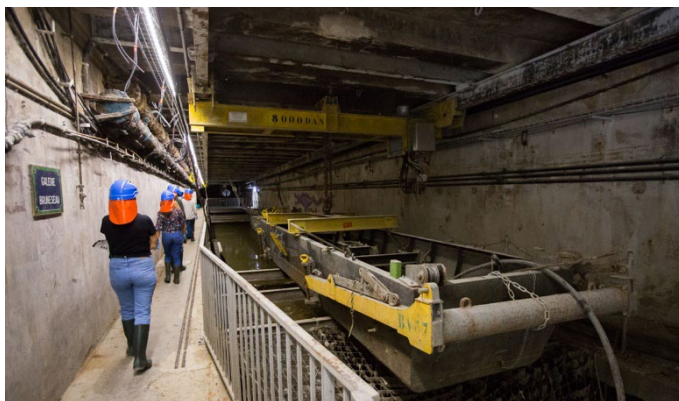
3 Intervention pour l'entretien des égouts de Paris. Source: Jean-Baptiste Gurliat, Ville de Paris
