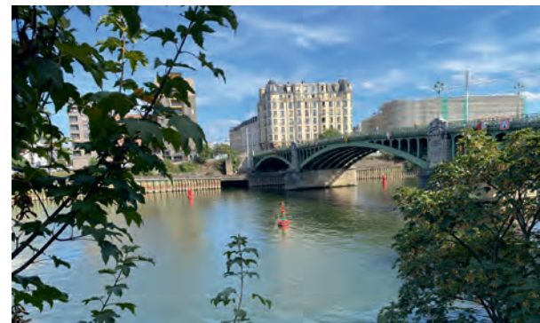
Le pont entre Saint-Denis et l'Île-Saint-Denis
