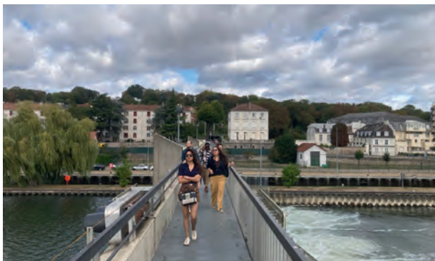
Le barrage d'Ablon-Sur-Seine
