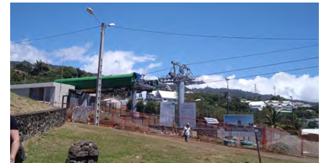
Téléphérique en préparation, Les Ateliers ©
