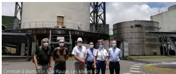
Centrale à biomasse, Bois Rouge, Les Ateliers ©
