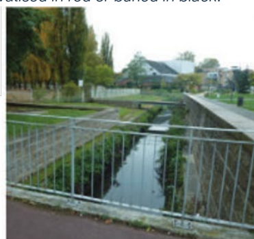
a) Le petit Rosne à Sarcelles (remise à ciel ouvert minérale réalisée en 2014)
