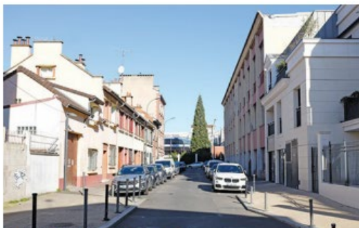
Rue Ambroise-Croisat, Saint-Ouen-sur-Seine
